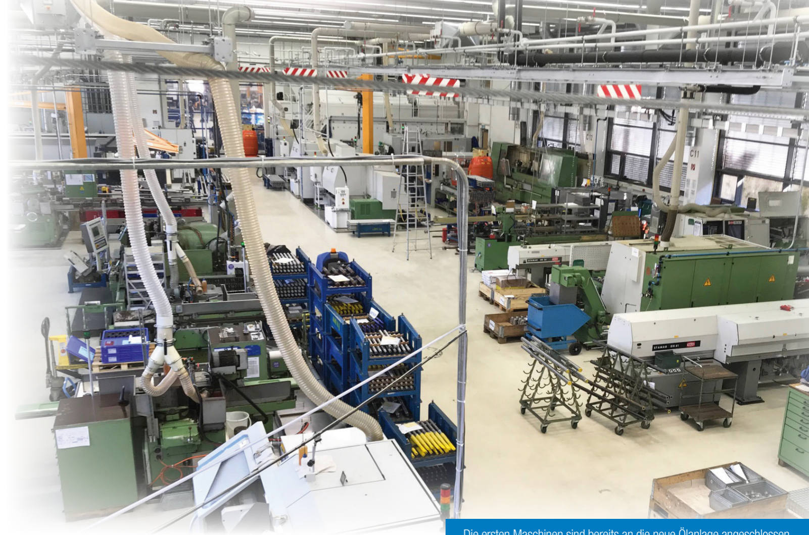
Die ersten Maschinen sind bereits an die neue Ölanlage angeschlossen.
